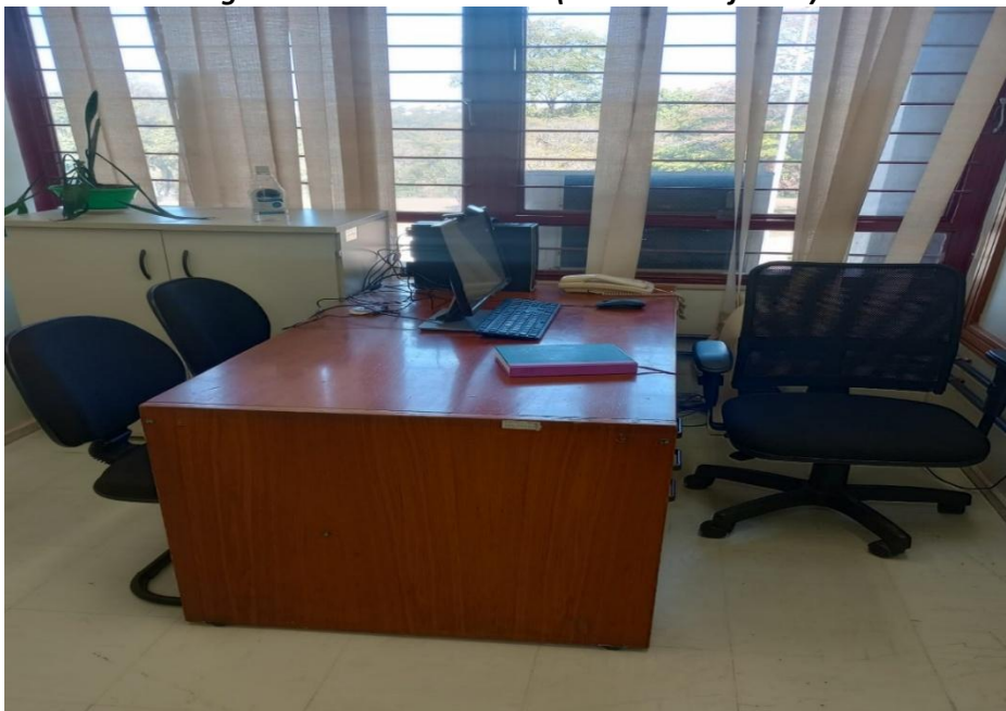
Figura 1: Sala da Ouvidora (durante a reforma)
